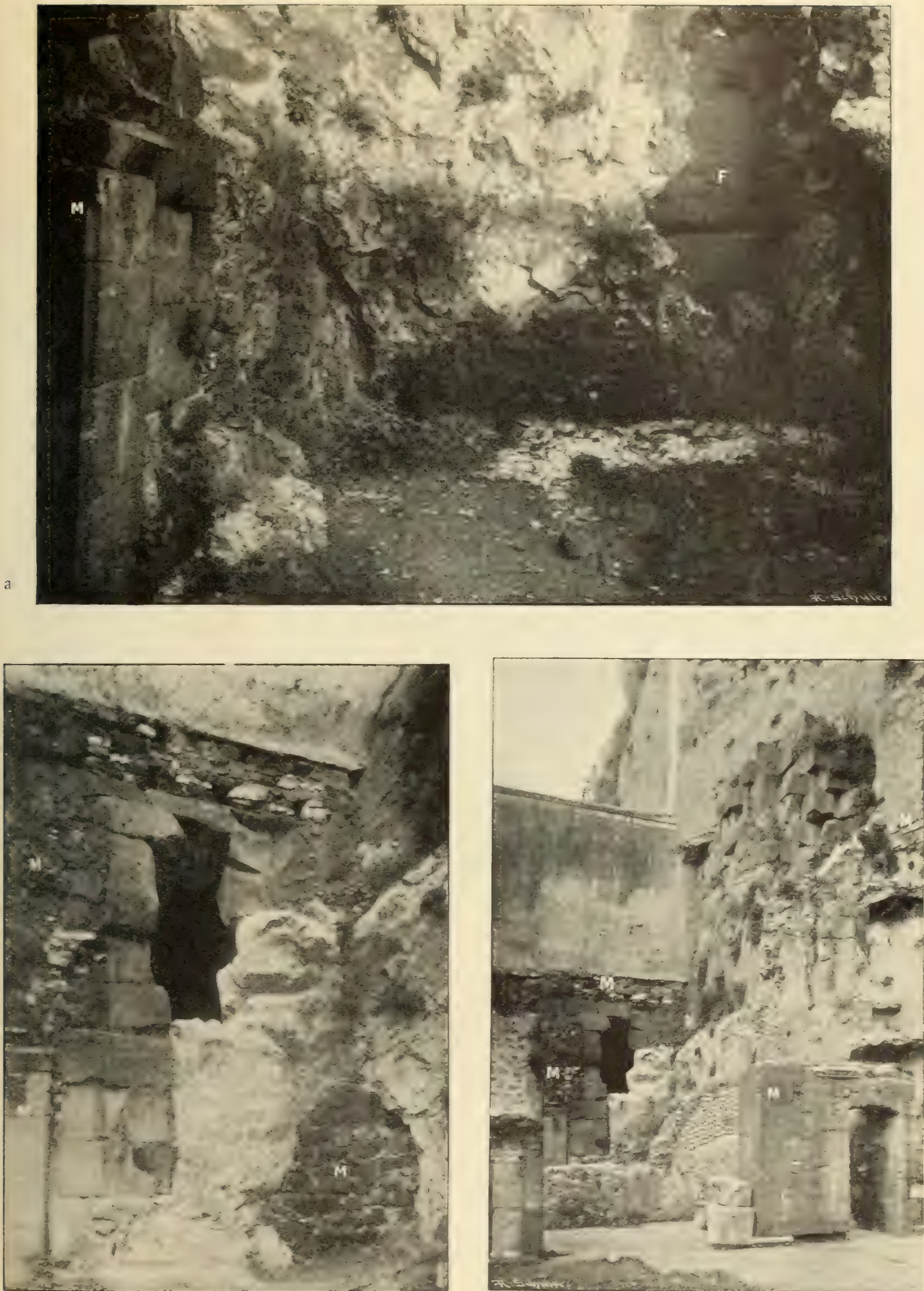
Abbildung 51. Der Nebenraum der Grotte. a. Ansicht von Süden; b. Westseite mit dem Grottengewölbe; c. Ansicht von Osten, mit der oberen Stützmauer. M = modern, F = Felsspalt.
